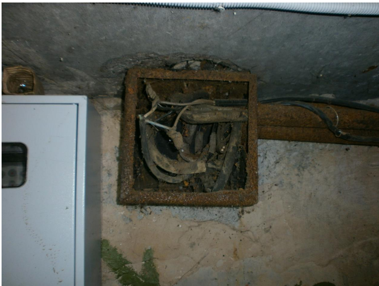
Фото 5. Вводно питающего кабеля в подвал от кабельного делителя
