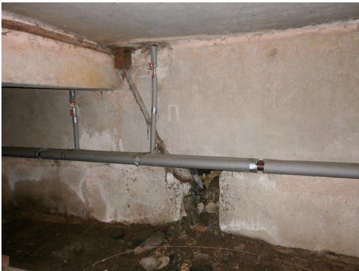
Фото 5. Вводно питающего кабеля в подвал от кабельного делителя
