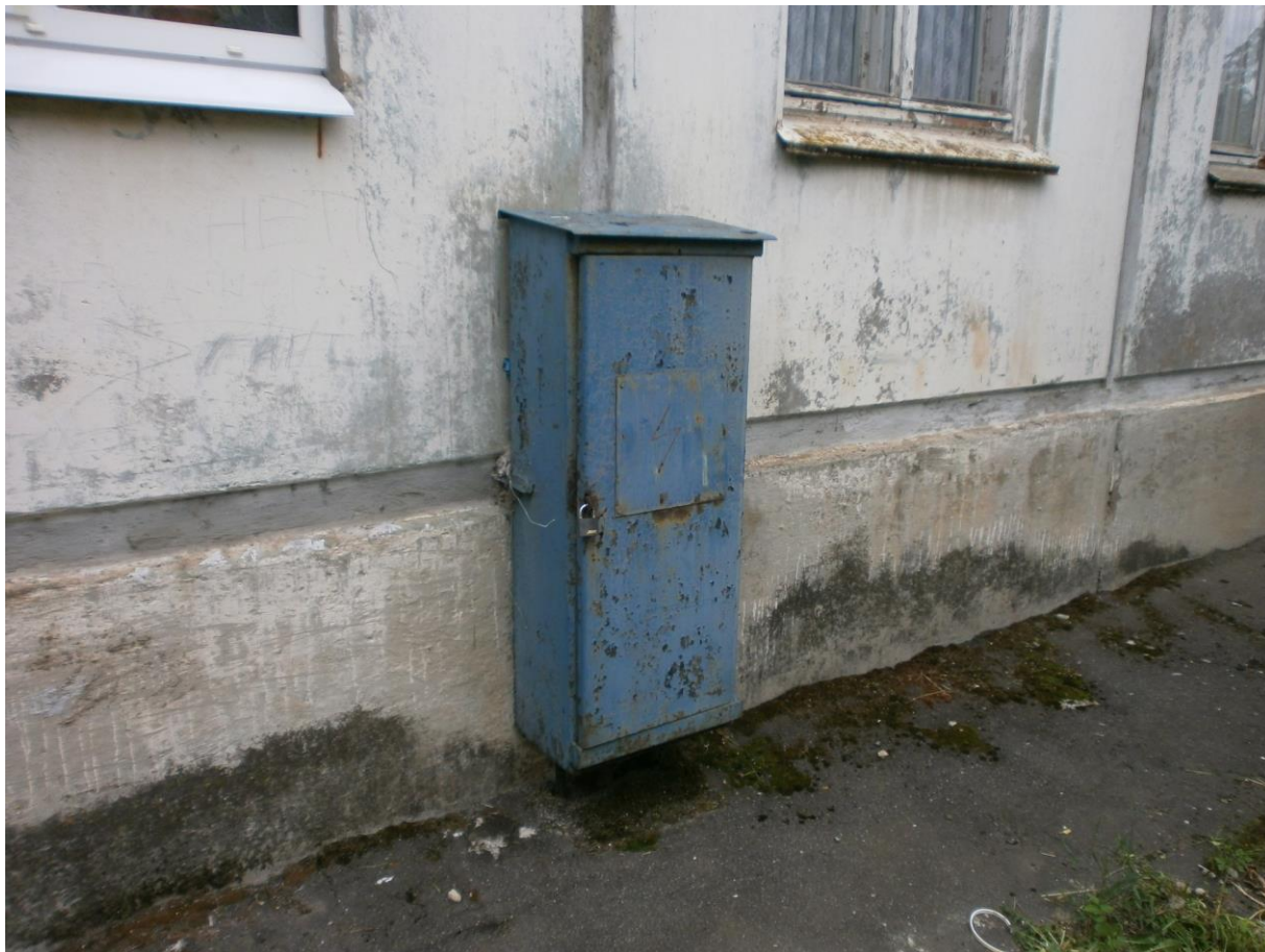
Фото 2. Кабельный киоск на стене дома
