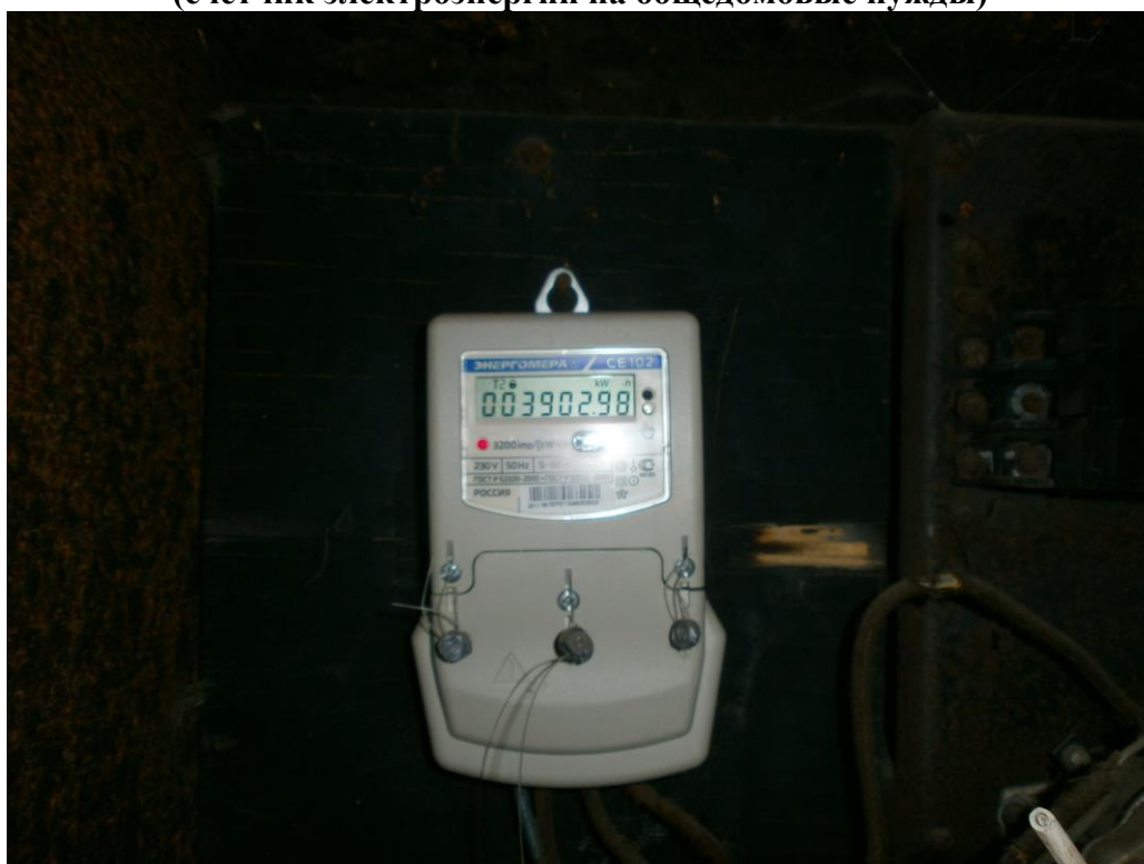
Фото 3.2 Вводно-распределительное устройство (счётчик электроэнергии на общедомовые нужды)
