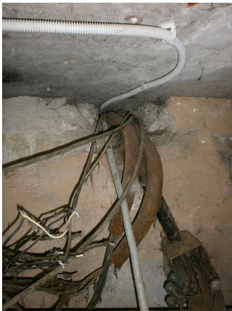
Фото 4.1 Прокладка питающего кабеля в подвальном помещении (ввод кабелей из вводно-распределительного устройства в подвал)
