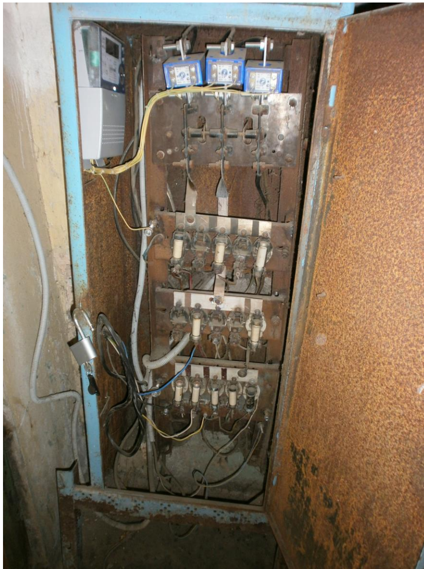
Фото 3.2 Вводно-распределительное устройство (счётчик электроэнергии на общедомовые нужды)
